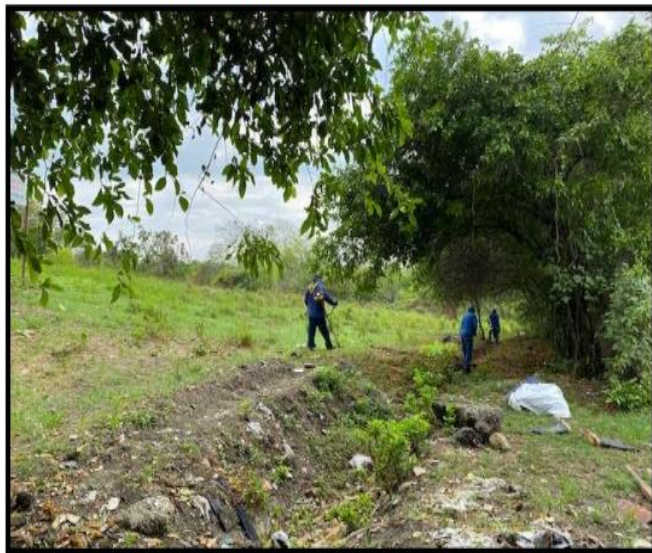
Imagen 1. Limpieza del terreno previo a la siembra de arboles
